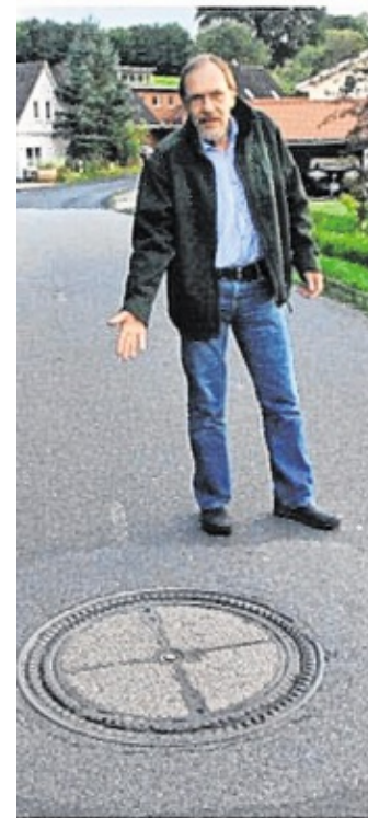
Ulrich Bärwald zeigt den Sprengschacht auf der Bestebrücke.
